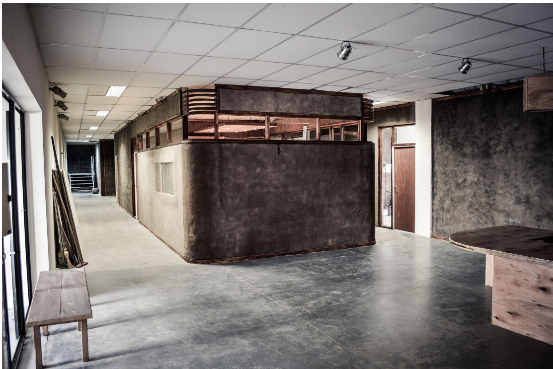
Figura 1a. Muros divisorios interiores con paja encofrada.
