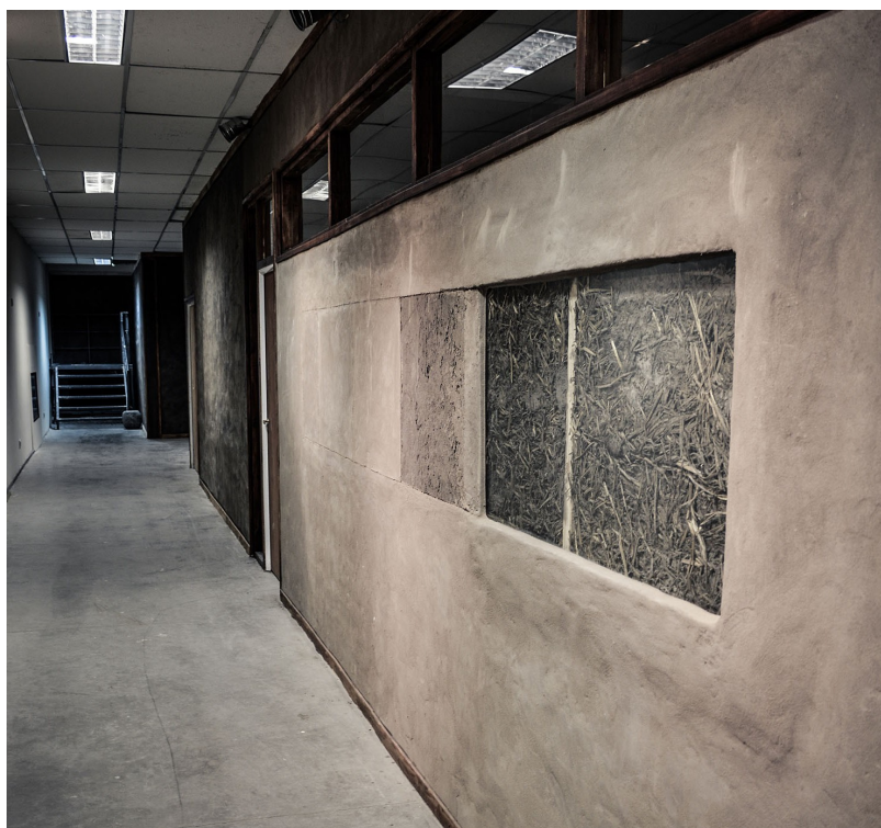
Figura 4. Muro de paja encofrada con ventana sin terminación mostrando materiales y detalle constructivo.
