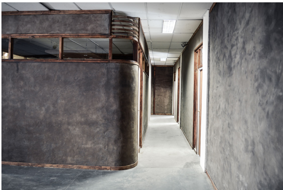
Figura 1b. Muros divisorios interiores con paja encofrada. Esquina.
