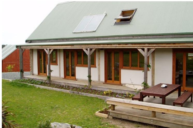
**Figura 11:** Fachada Norte, mayor apertura de vanos, galería como espacio intermedio y de parasol en verano, uso de paneles solares.
