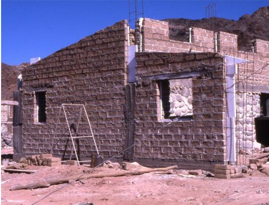
**Figura 24.** Muro-doble de adobe con aislación
