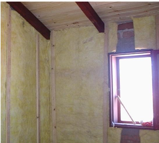
Figura 16. Aislaciones en los muros
