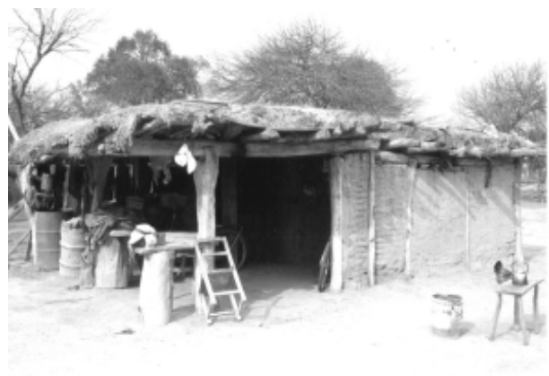
Casa tradicional de adobe en Santiago del Estero (foto: R. Rotondaro)
