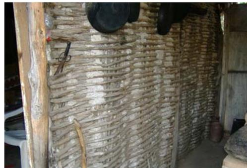
**Figuras 7 y 8.** Perspectivas de la fachada y el interior de una vivienda del tipo cerco chiname con barro.
