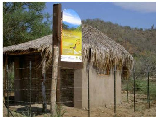
**Figura 4.** Se aprecia el letrero de bienvenida a la reserva, donde se puede observar ya un tipo de construcción característico de la zona a base de cerco chiname con barro.
