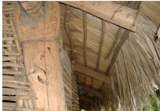
**Figuras 5 y 6.** Detalles del interior y la techumbre de una vivienda del tipo cerco chiname.
