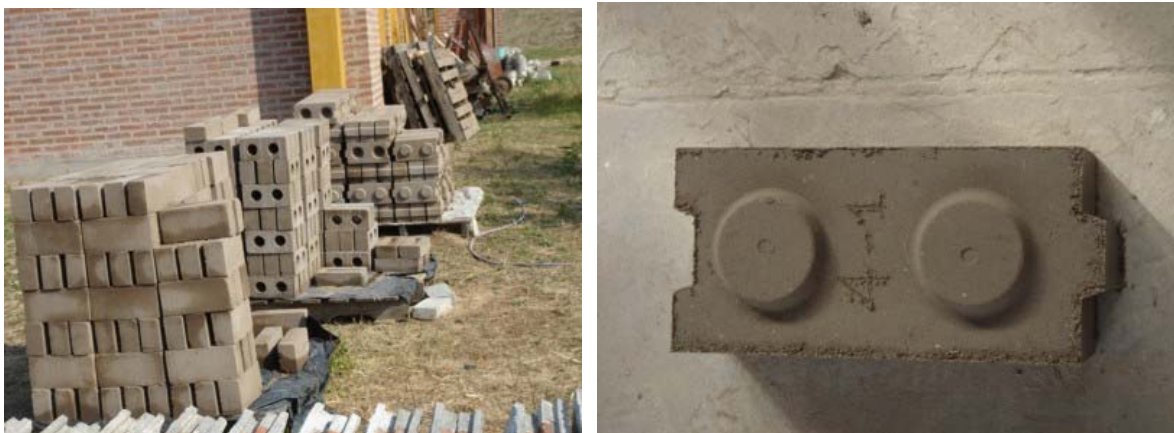
Figura 4: Bloque intertrabado. Area de acopio.
