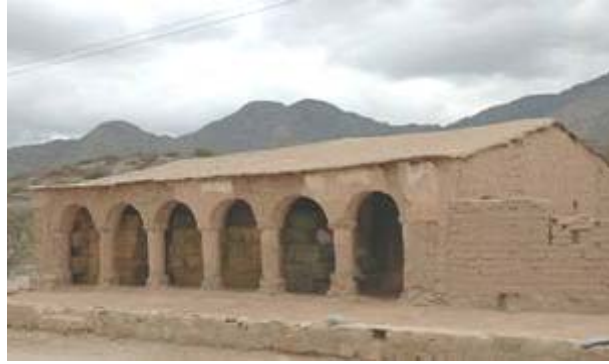
Fig. 4. Vivienda en camino Molinos
