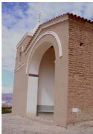
Figura 13. Fachada Iglesia del Carmen
