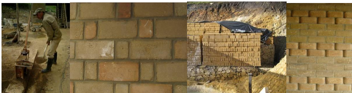
Figuras 8, 9 10 y 11. Sistema de albañilería en BTC / Vivienda Principal / Casa Prior.
