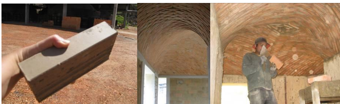
Figuras 12, 13 y 14. Bóvedas mexicanas en la vivienda principal y acceso de Casa Prior
