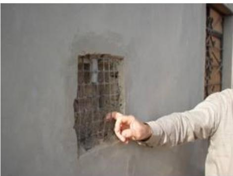
**Figura 1.** Detalles de la geomalla, técnica para mejorar muros de viviendas en adobe.
