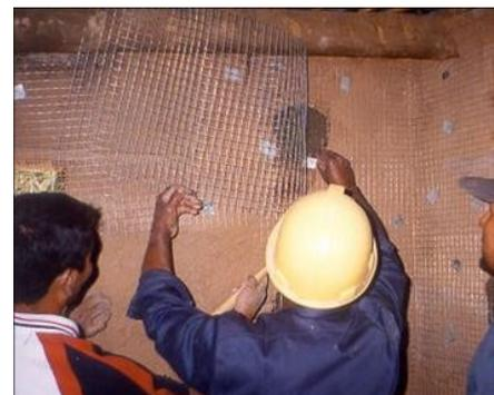
**Figura 2.** Refuerzo con red metálica.
