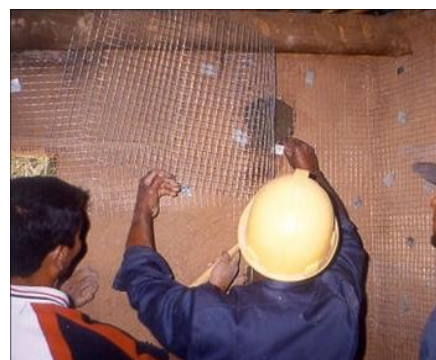
Figura 2. Refuerzo con red metálica.
