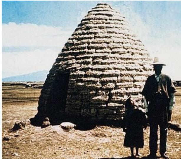
**Figura 1 y 2** Viviendas en forma de cúpula conica construida con tepes
