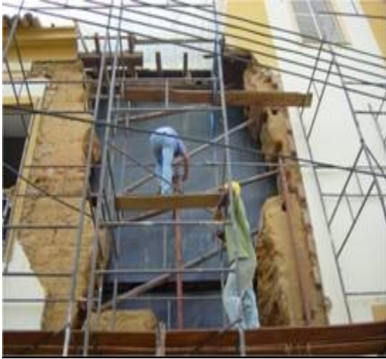
Figura 4. Finalización de los trabajos de demolición del área colapsada. Enero 2006
