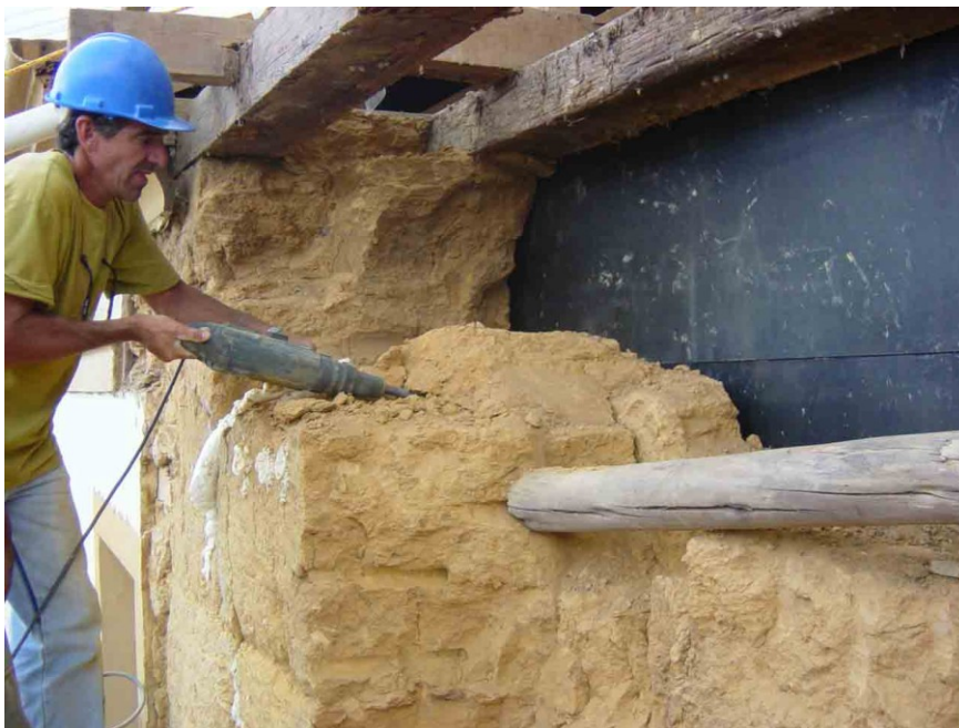
Figura 3. El proceso de demolición de los bloques de la tapia antigua. Nov. 2005.
