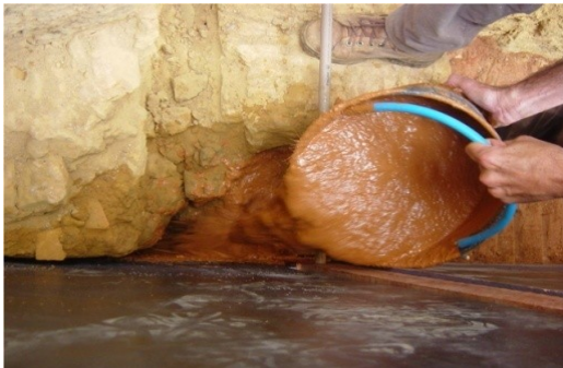
Figura 6. Unión de vacíos con barro reforzado.
