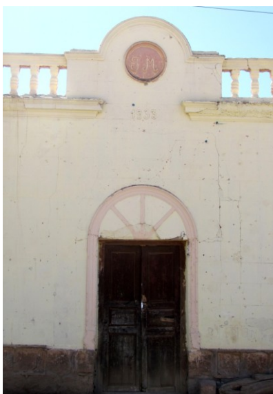
Figura 13. Puerta de acceso con fecha de construcción.
