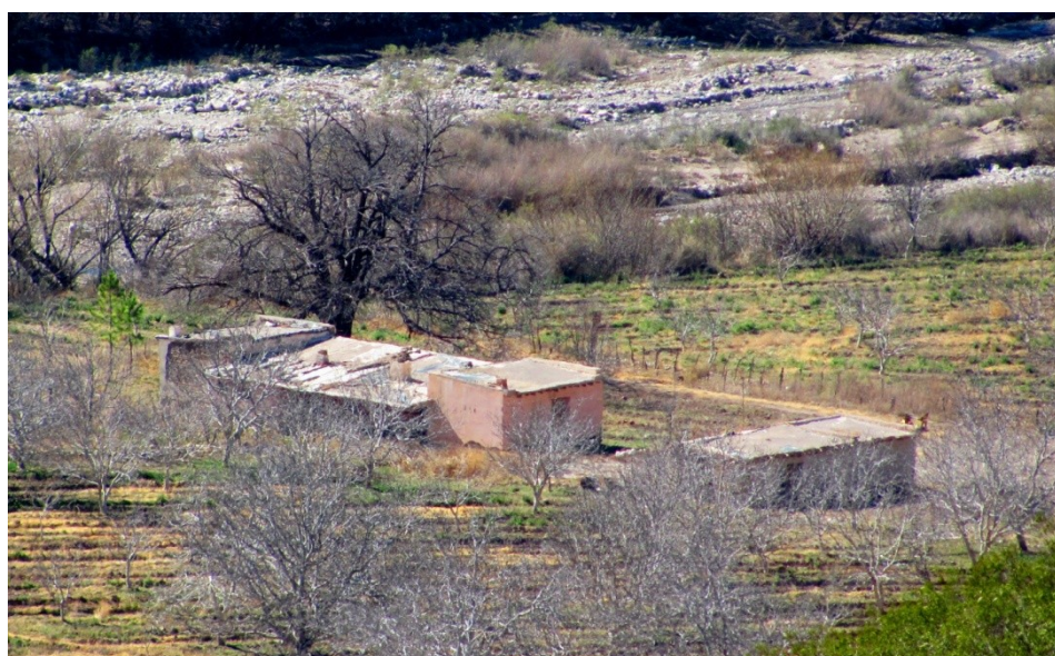
Figura 3. Vista de la casa desde el sector superior del camino
