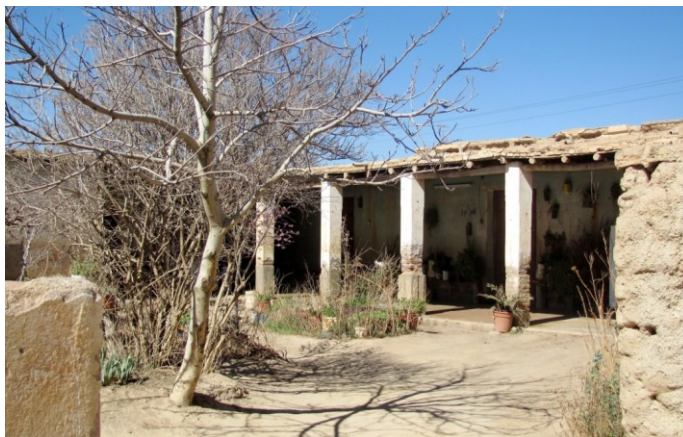
Figura 9. Galería interior de una vivienda.
