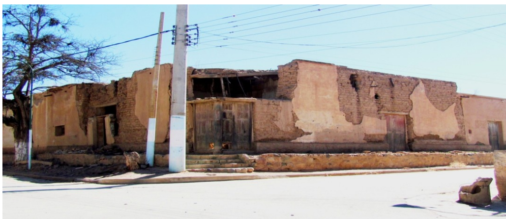
Figura 11. Vista del estado actual de la Casa Salcedo.
