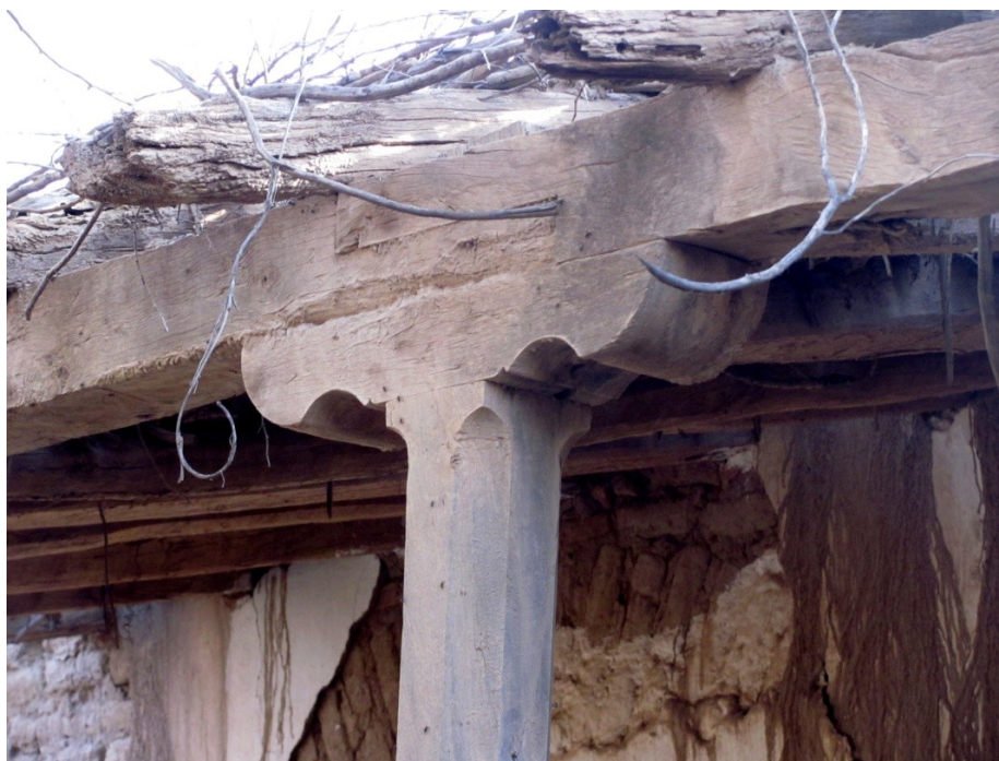
Figura 17. Detalle de la estructura de la galería.
