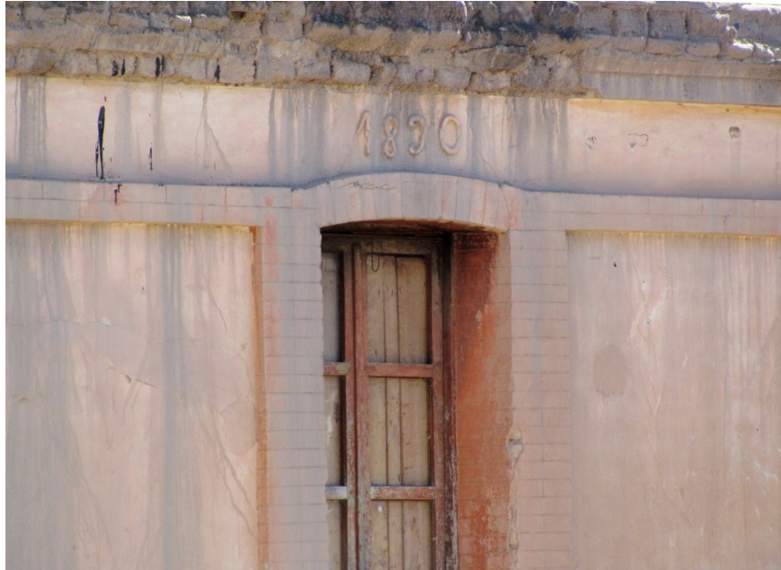
Figura 4. Detalle de la entrada con la fecha de construcción.
