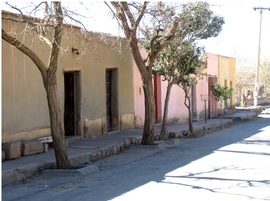
Figura 8. Viviendas en Alto Carrizal
