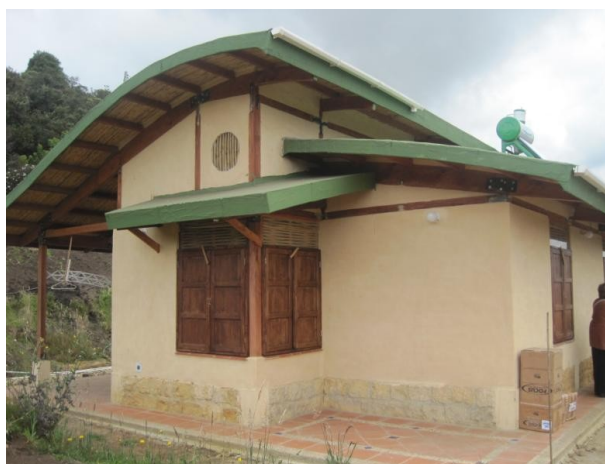
Figura 7. Casa de quincha racionalizada, vista de la fachada oeste (Garzón, 2012).
