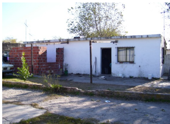
Figura 5. Vivienda de autoconstrucción con bloques de hormigón, Gran Buenos Aires.
