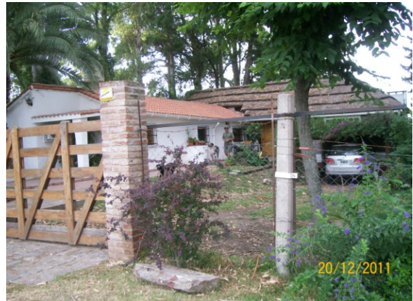
Figura 11. Vivienda construida en BTC y material tradicional. Paraná, Argentina.
