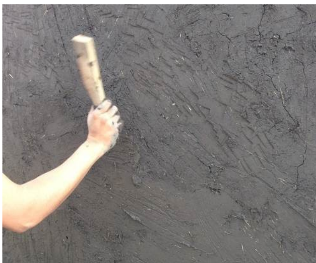
Figura 7. Para la compactación de los revestimientos se usaron mazos de madera de aproximadamente 200g. Módulos experimentales en el norte de la Ciudad de México.
