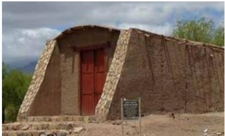
**Figura 4.** Capilla de Anillaco: se ha perdido parte de la nave. Los muros han sido cortados en diagonal. Fuente: CIHE, 3. 2007.
