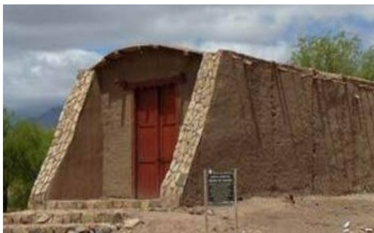
Figura 4. Capilla de Anillaco: se ha perdido parte de la nave. Los muros han sido cortados en diagonal. Fuente: CIHE, 3. 2007.
