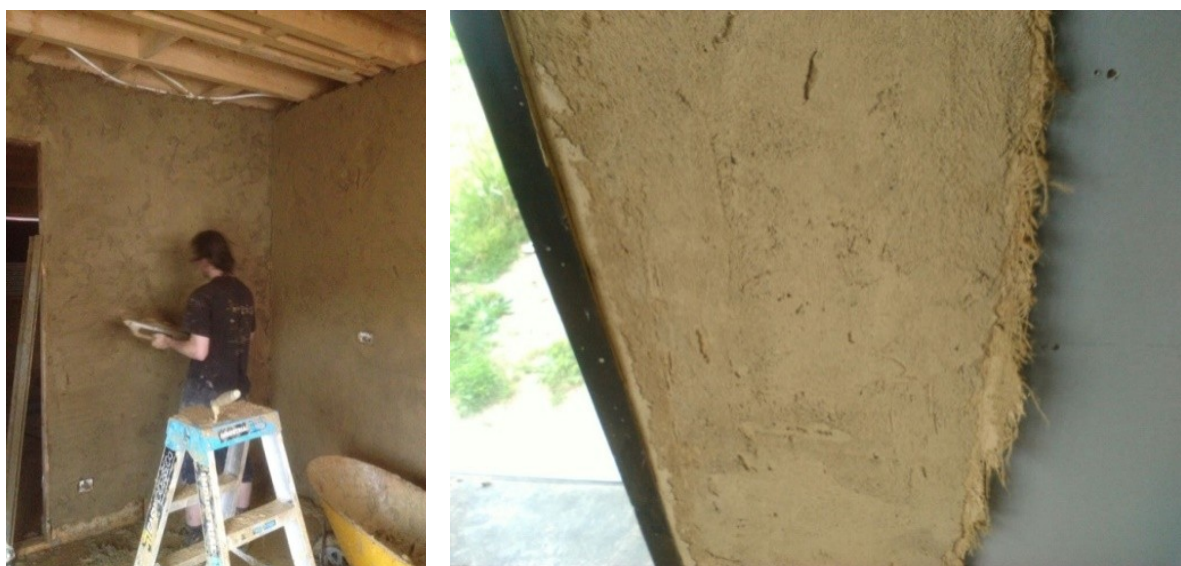
Figuras 8a y 8b: se observa el adobe alivianada con la malla de tela arpillera para evitar fisuras.
