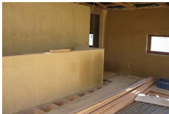
Figura 4. Revoque fino adobe aliv. terminación.
