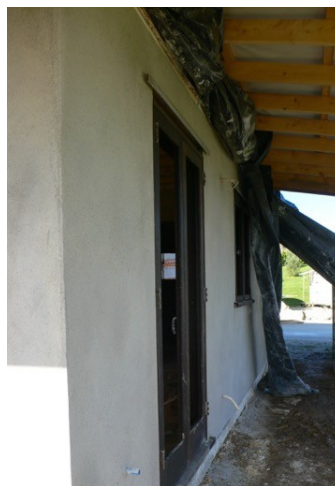
Figura 4. Revoque fino adobe aliv. terminación.
