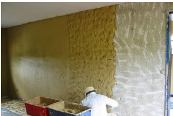
Figura 3. Revoque int. adobe aliv. en proceso
