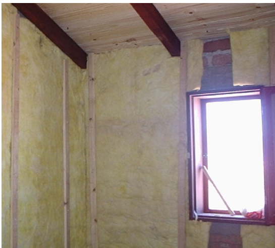
Figura 16. Aislaciones en los muros
