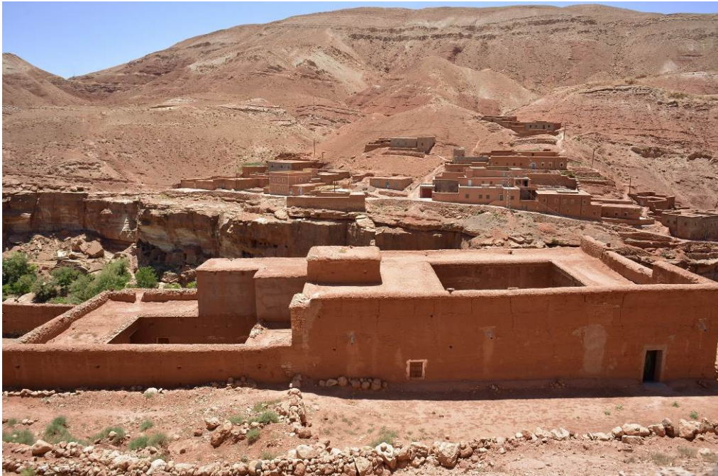
Figura 2. Vivienda de adobe en Marruecos.
