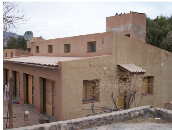
Figura 27. Vivienda en su estado actual.
