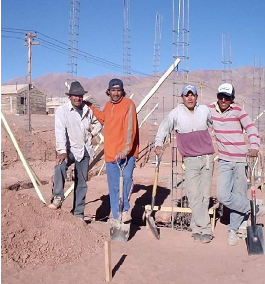
Figura 14. Mano de obra local
