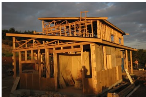
Figuras 1 y 2. Estructura de madera y cerramiento de adobe alivianado, y diagonales rigidizando el sistema.
