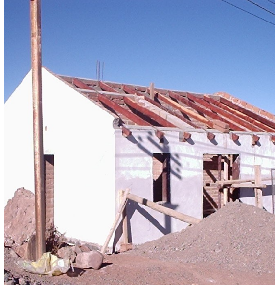
Figura 15. Muros de adobe
