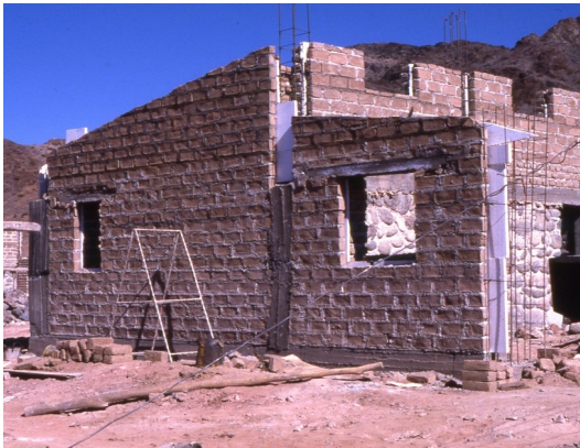
Figura 24. Muro-doble de adobe con aislación
