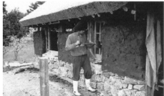
Emparejando el Plomo y Nivel con Pala
