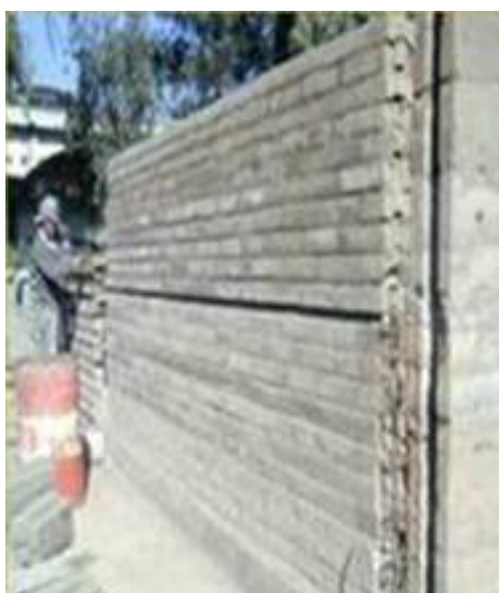
fig. 2 Bloque articulado de suelo-cementocomprimido
