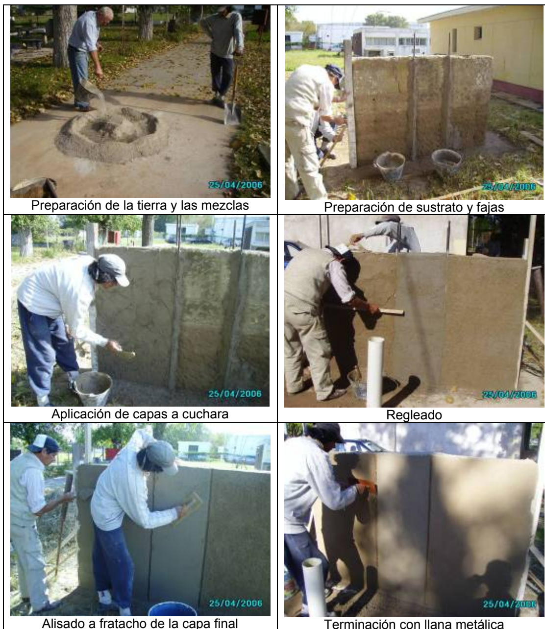
Cuadro 3: Secuencia constructiva de los revoques bicapa en Florencio Varela
