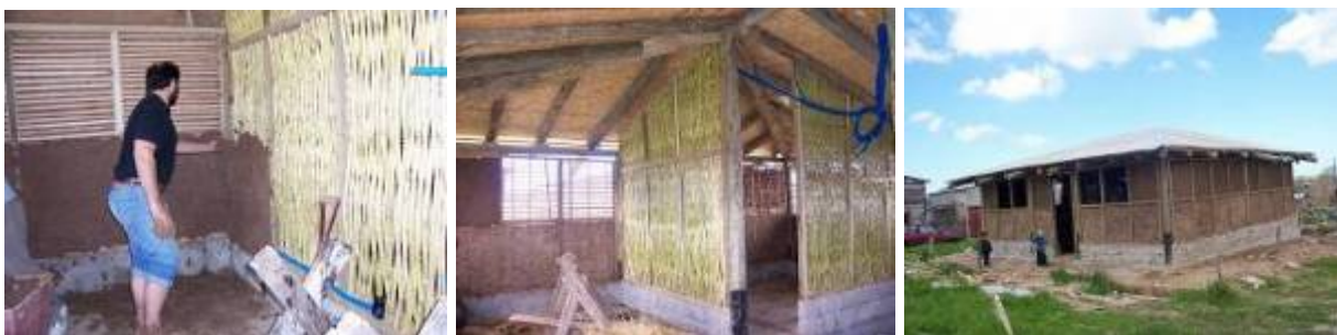
Montevideo – Construcción Prototipo en Fajina – año 2005
