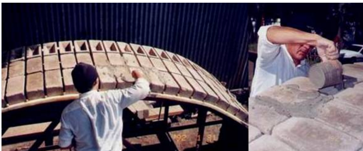
fig. 5 Construcción bóveda
