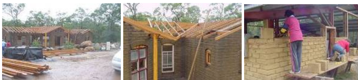
Australia – Construcción en BTC
