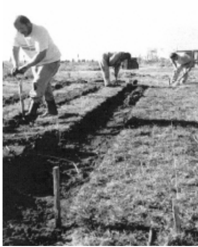
Corte y Extracción de Terrones
