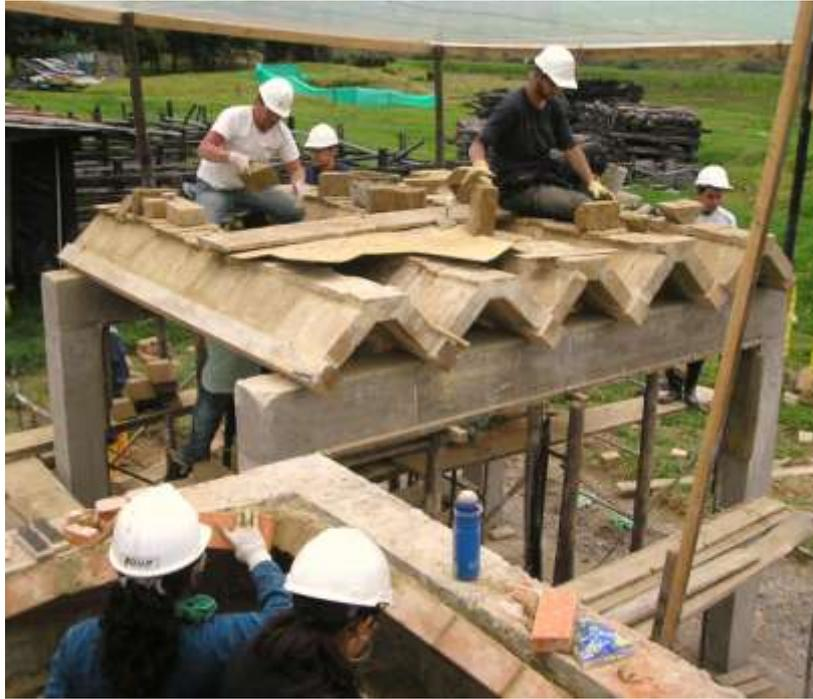
**Figura 10.** Bovedillas en proceso
