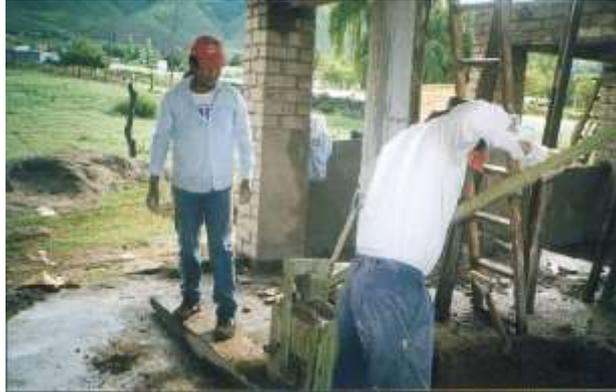
Figura 12. Construcción con BTC.
