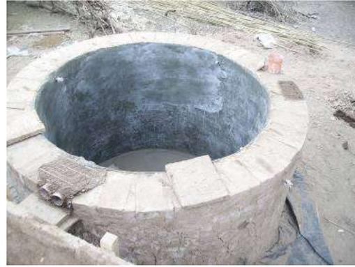
**Figura 5 - Construcción cisterna**
