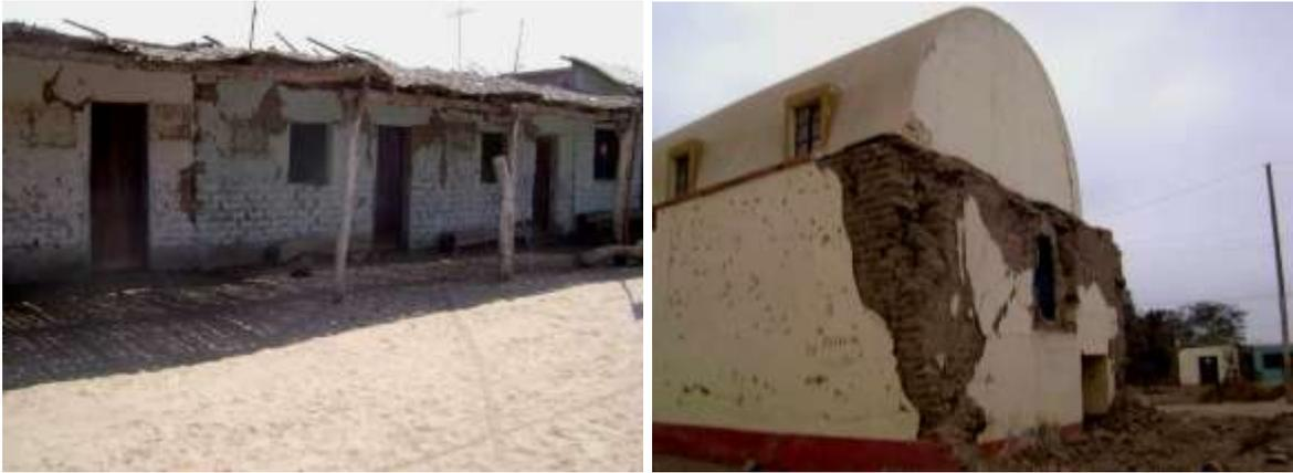
Figuras 10 y 11. Construcciones en tierra después del terremoto, Lima, 2007.
