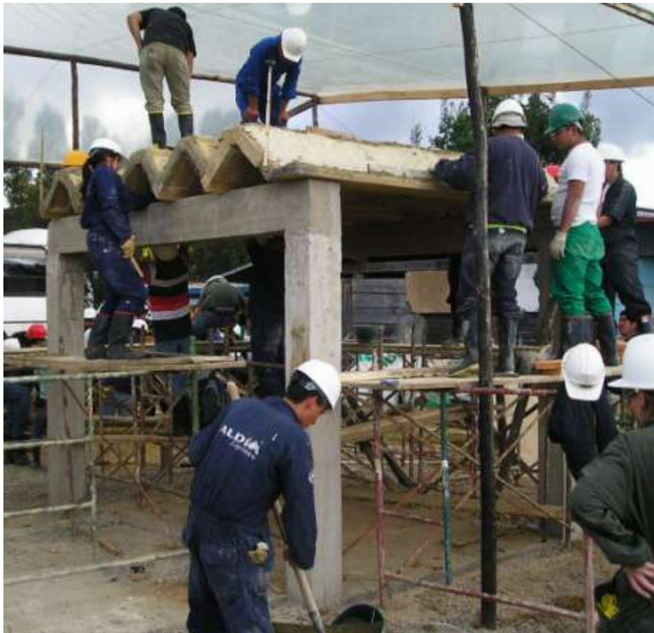
**Figura 5.** Bovedillas con bloque de tierra comprimido
