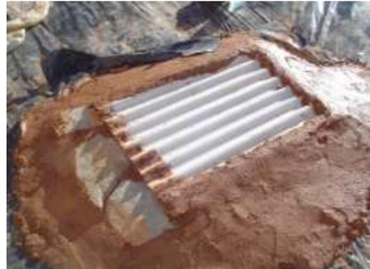
**Figuras 8 y 9.** Proceso de armado de las lucarnas. Primero la colocación del plástico y luego el torteado.
