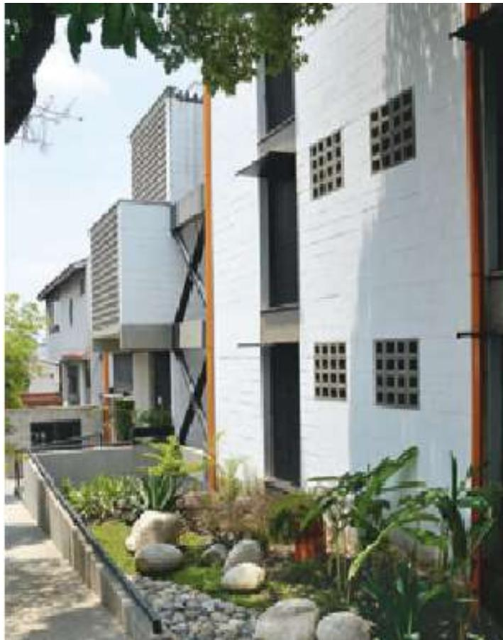
**Figuras 11.** Edificio San Fernando, Cali. Muros cargueros rellenos con tierra (2009). Arq. BBC
