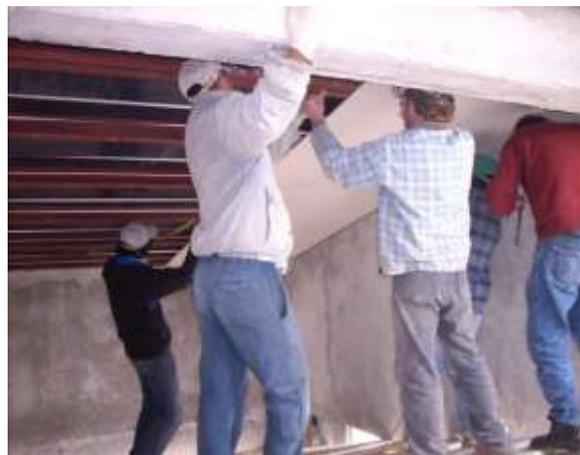
**Figura 9.** Colocación de cielorraso.
