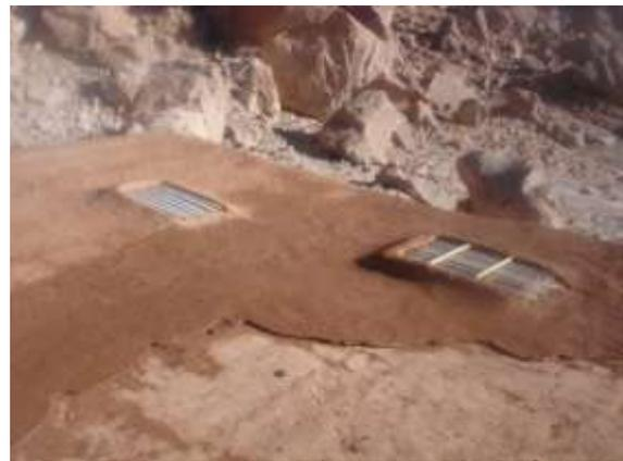
Figuras 6 y 7. Colocación de la primera y la segunda capa de barro sobre el techo.
