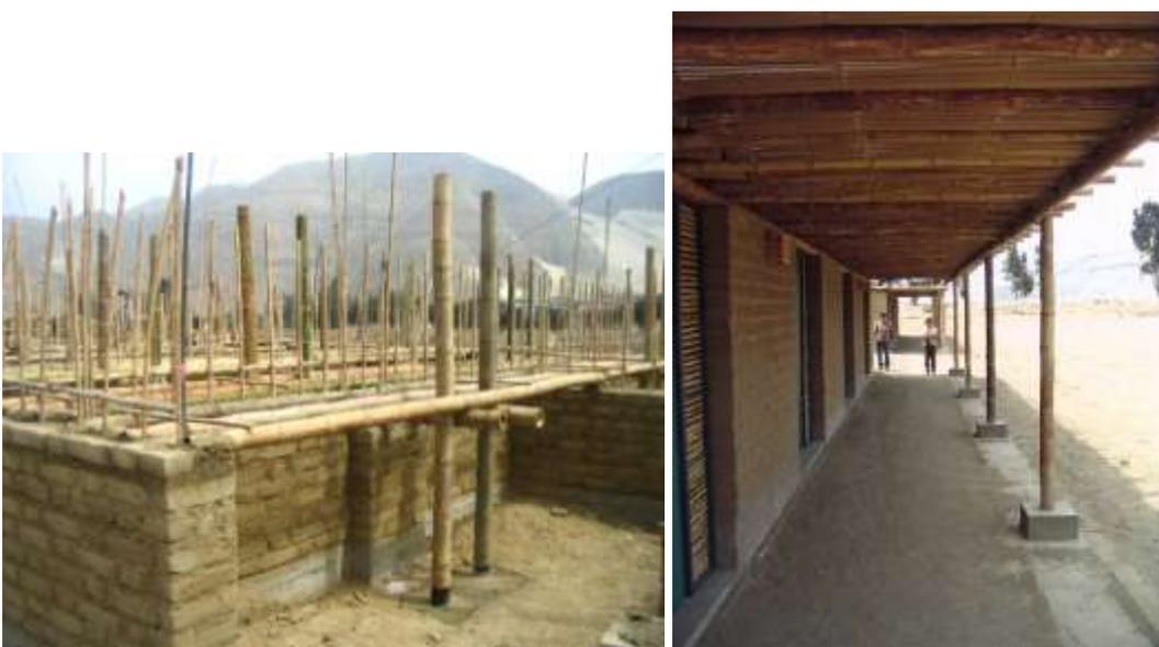
**Figura 15.** Construcción anti-sísmica con muros de tierra y caña brava.
