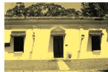
Fig. 98 - Construcción del casco de la estancia Santa Elena - Libro "Malvinas Argentinas un partido que esta haciendo historia". 1999 - Municipalidad de Malvinas Argentinas - Secretaría de Gobierno.
