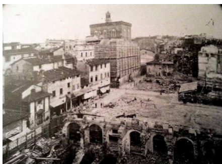
Fig. 7. Demolición de la plaza del Mercado viejo
