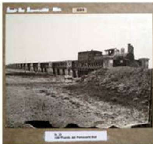
Puente del Ferrocarril del sud
