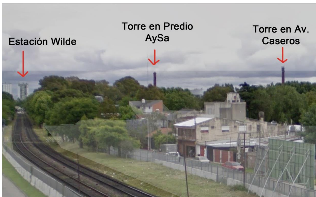
Fotografía tomada desde el puente del Acceso Sudeste, donde se observa la cercanía entre ambas torres
