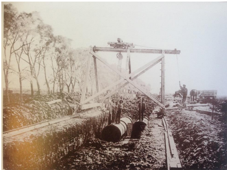
Imagen de los conductos cloacales atravesando el bañado de Quilmes. Año 1884. Fuente: Museo del Agua y de la Historia Sanitaria, AySA
