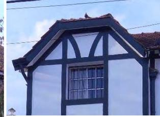
Ya se pueden ver en las fotografías anteriores los diseños realizados en las partes de los tímpanos con el uso de **gabletes** representando en la fachada las formas de construcción en madera típicas del norte de Europa. Si bien lo más común es observarlas en la parte superior de las fachadas, muchas veces terminan siendo verdaderos articuladores de todo el frente o de los pisos altos.
