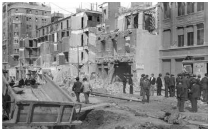
Trabajos de demolición de los edificios de la calle Corrientes (1935). Archivo Fotográfico, Secretaría de Planeamiento
