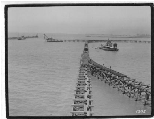
Obras de construcción de Pto. Nuevo 1912
