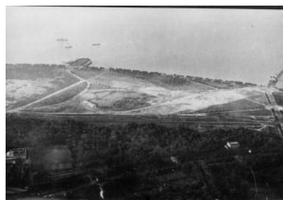
Vista aérea del terreno del aeroparque antes su construcción 1940
