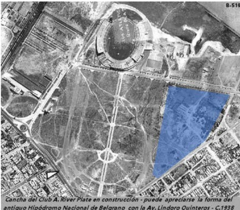
Cancha del Club A. River Plate en construcción - puede apreciarse la forma del antiguo Hipódromo Nacional de Belgrano con la Av. Lindoro Quinteros - C.1938
