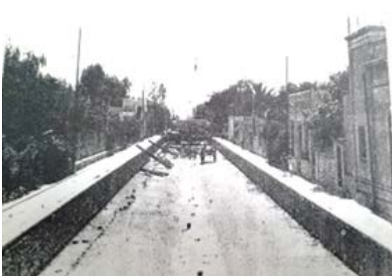
Foto 1: Iniciación de los trabajos de construcción del conducto de 7m de ancho. Levantamiento del afirmado y colocación de una canaleta para recoger las aguas ordinarias que circulan por el cauce. (Blanco Encalada, entre Avenida del Tejar y Crámer) Foto 2: Obras de entubamiento y asfaltado terminadas. Foto 3: Situación actual.
