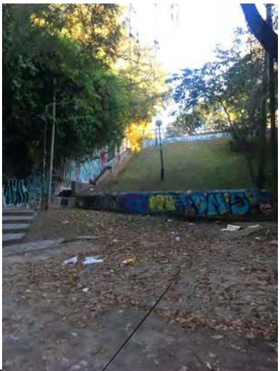
Bajada a calle cortada, se ve basura tirada y mucho del asfalto levantado por las raíces de los árboles.
