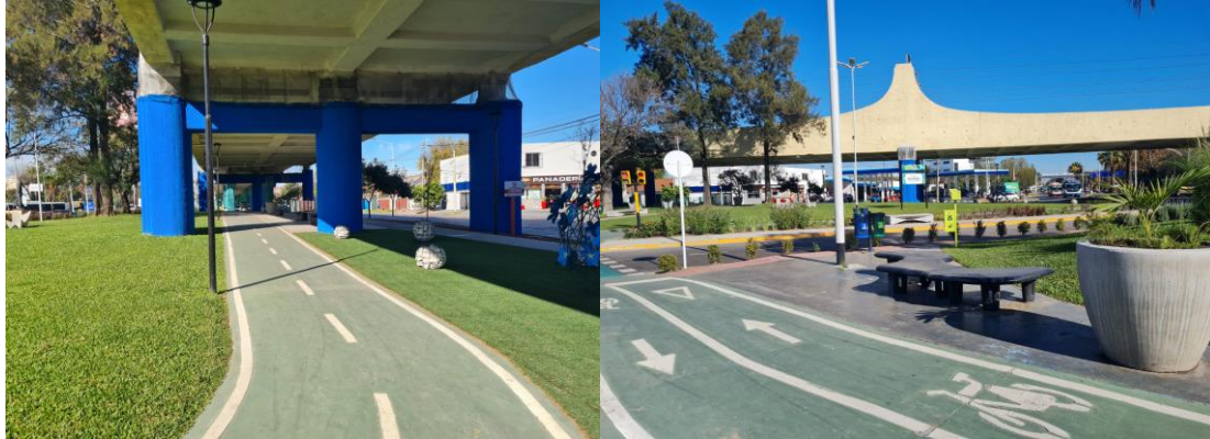
Figura 4. Bicisendas en bajo viaducto e isleta. Fuente: Fotografía propia.
