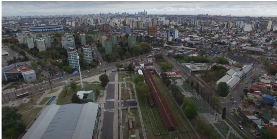
Figura 2. Vista hacia el norte de la estación Avellaneda ex Ferrocarril Provincial desde drone. Fuente: Fotografía propia.
