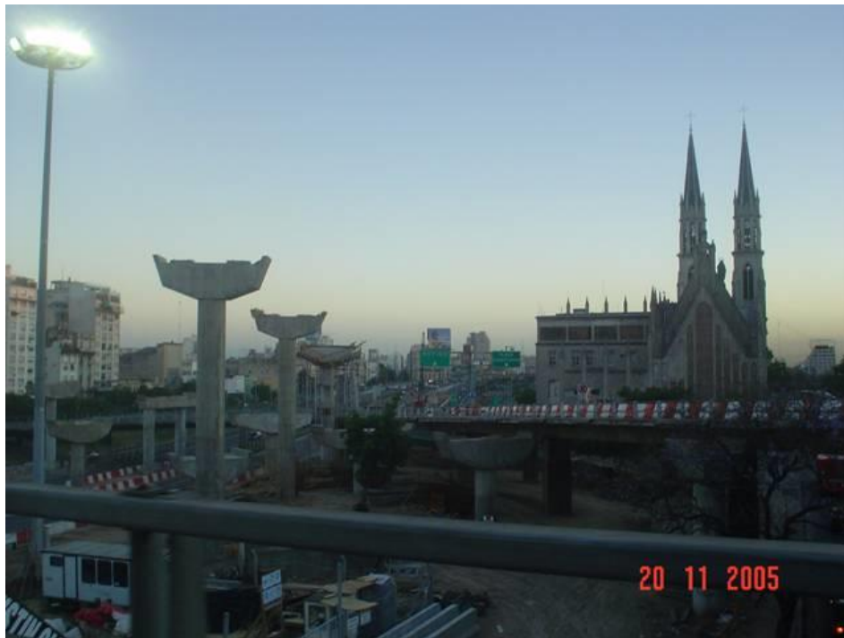
Imagen 4. Obras del distribuidor vial Autopista 25 de Mayo-9 de Julio (2005). Fuente: Fotografía propia.
