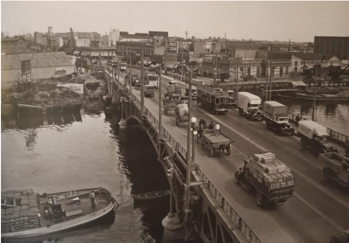
Imagen 3. Puente Pueyrredón (1931). Fuente: Dirección de Construcciones Portuarias y vías navegables
